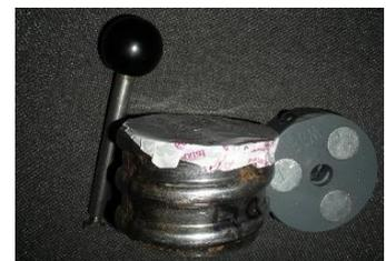
Damit kein Zementleim in die Öffnung eindringen kann und dadurch das Einbauteil und das Magnetsystem beschädigt werden könnte, wird das Einbauteil mittels Klebeband verschlossen.
