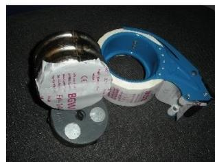
Damit kein Zementleim in die Öffnung eindringen kann und dadurch das Einbauteil und das Magnetsystem beschädigt werden könnte, wird das Einbauteil mittels Klebeband verschlossen.
